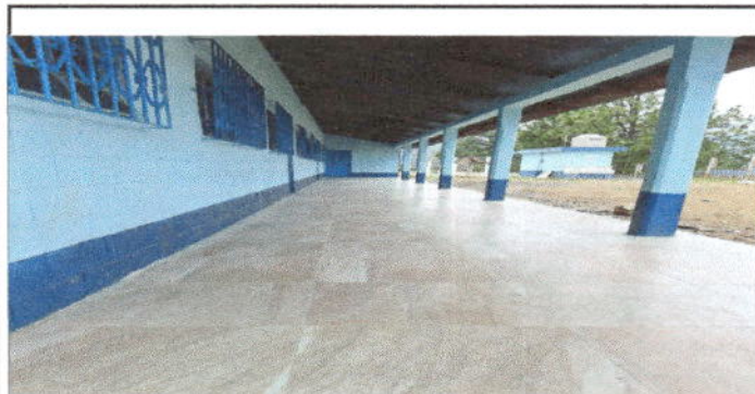
Foto 3: finalizacion de sustitucion de piso ceramicon en el corredor de las tres aulas
