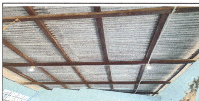
Foto 6: finalizacion de reparacion de sistema electrico en aulas y corredor
