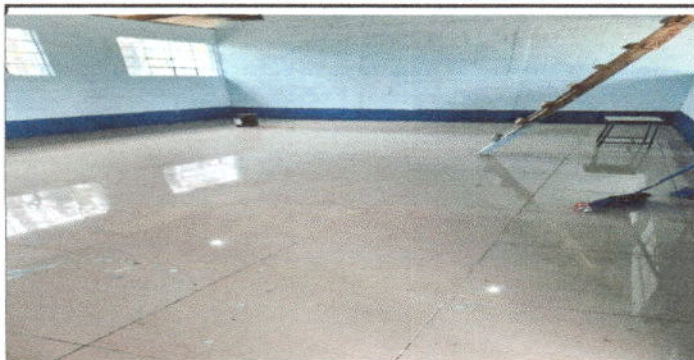
Foto1: finalizacion de sustitucion de piso cerámico en aulas
