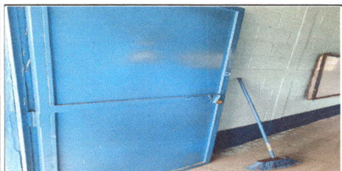
Foto 5: finalizacon de pintada de puertas y colocacion de chapas nuevas YALLE
