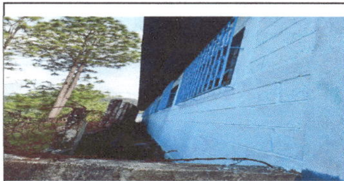
Foto 4: finalización de pintada de balcones y pared
